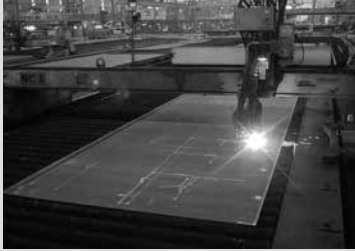
鉄板の切り出し
