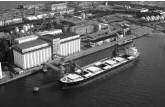
ちよぞうそう 貯蔵槽倉庫（サイロ）
