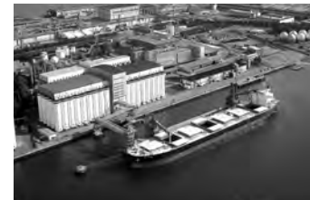
貯蔵槽倉庫 (サイロ)
