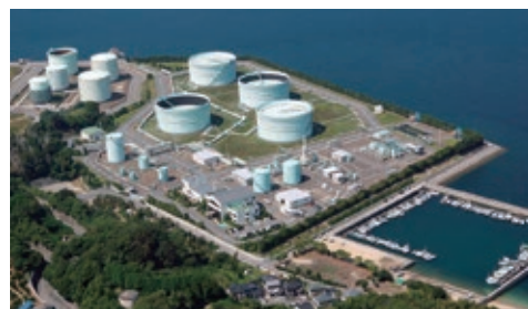
菊間国家石油備蓄基地
