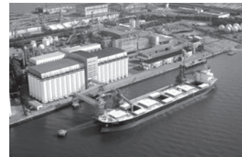
貯蔵槽倉庫 (サイロ)
