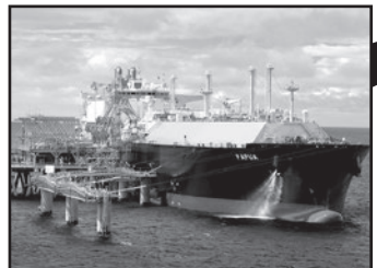
船に積まれた液化天然ガス(LNG)を、基地からパイプラインで、陸の貯蔵タンクへと送ります。
