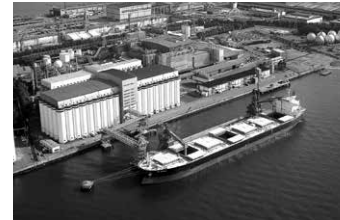
貯蔵槽倉庫 (サイロ)
